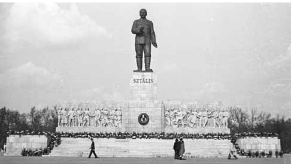
A Sztálin-szobor 10 méter magas talapzata vörös mészkőből, a 8 méter magas szobor bronzból készült (1953)
