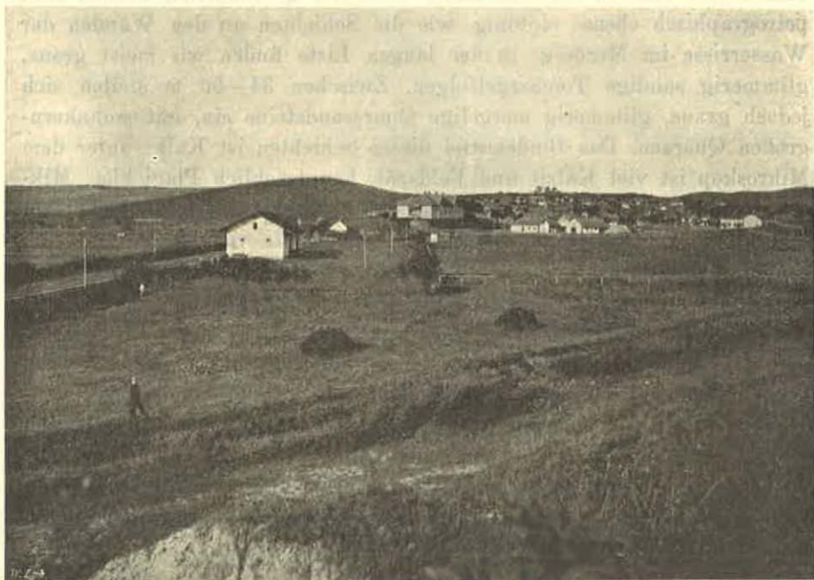
Fig. 3. Der auf Kalisalz ausgesteckte Bohrpunkt Nr. I, neben der Eisenbahnstation Nagysármás, am 9. September 1907.
