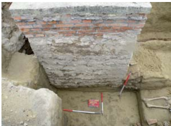
17. ábra: A középső, nagy pilléralapozások egyike (a felső része újkori hozzáépítés)
