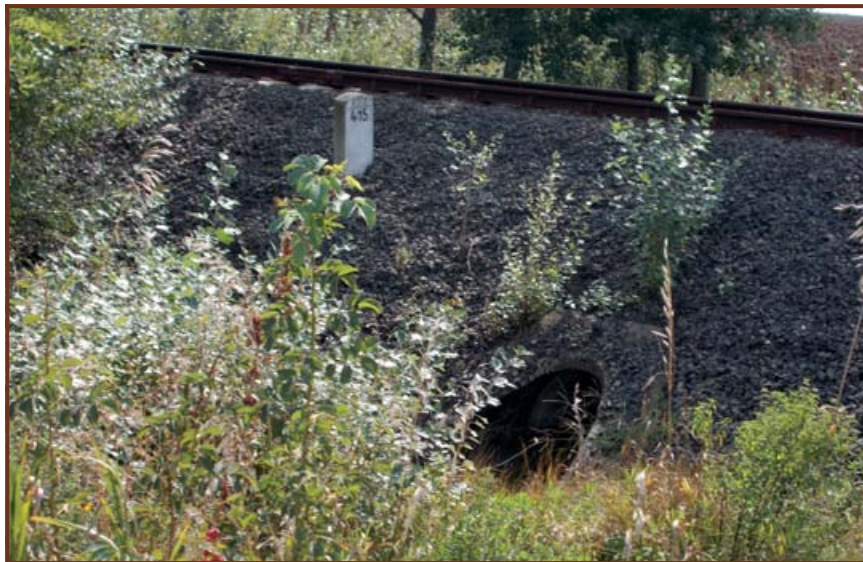
A Holt-Tarna egyik ágának áteresze a vasúti töltés alatt Jászdózsa határában
