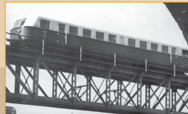
Sínautóbusz a biatorbágyi új viadukton, 1936
