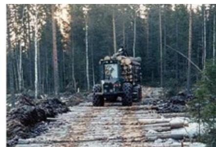
4. ábra. Fából készült útpálya (Horvath A., 2015)
