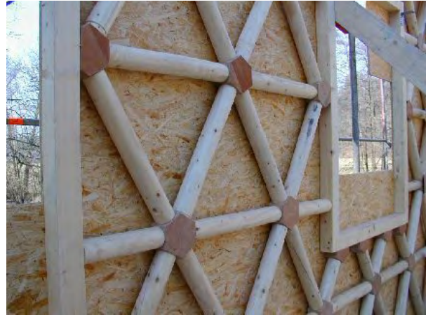
11.ábra A „BAMBUTEC” mint faházak vázszerkezete
