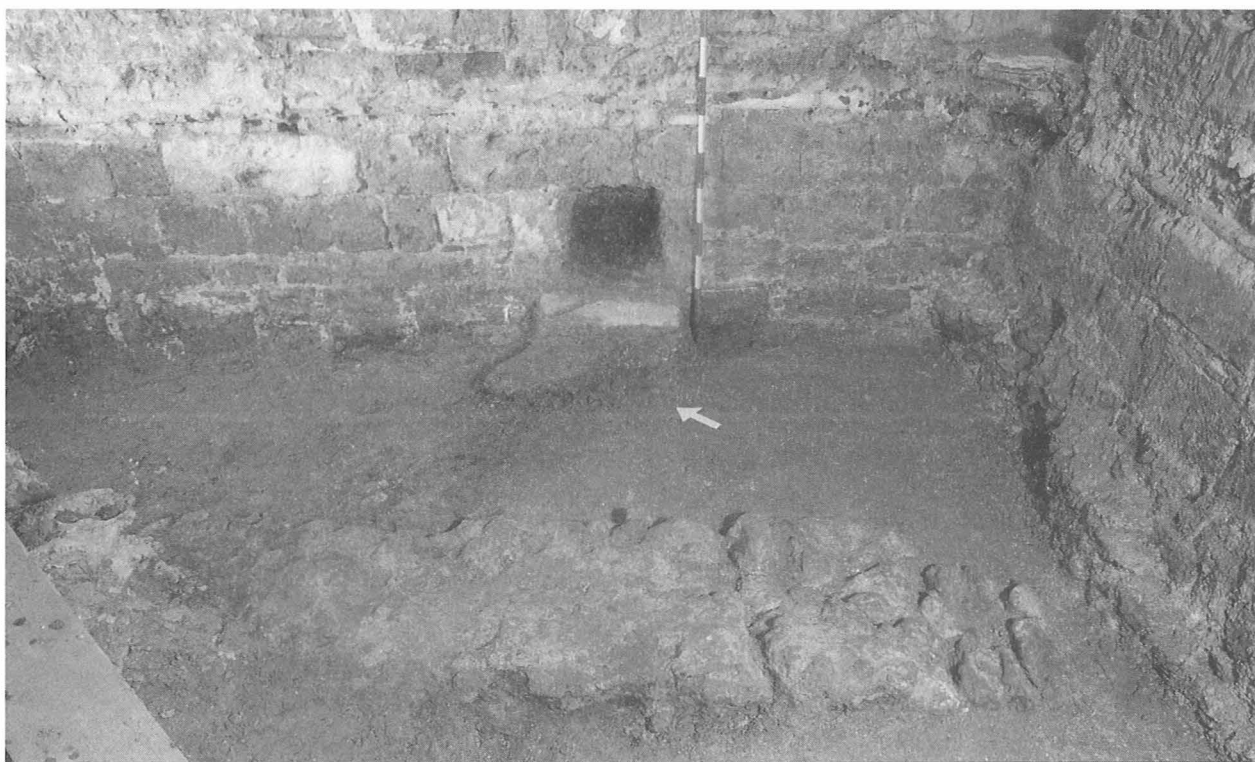
28. kép: Bp., Rudas fürdő. A kupolatérben felszínre került, erősen visszabontott középkori fal
