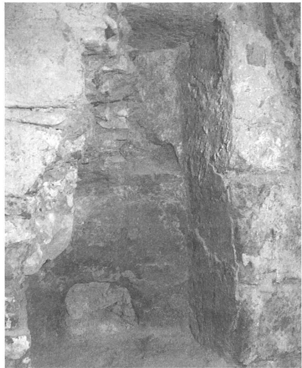
6. kép: Bp., Rudas fürdő. A 26. helyiség északi falában talált török fülke kibontás után
