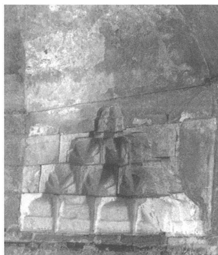
17. kép: Bp., Rudas fürdő. A kupolatér sarkaiban látható török sztalaktit boltozat
