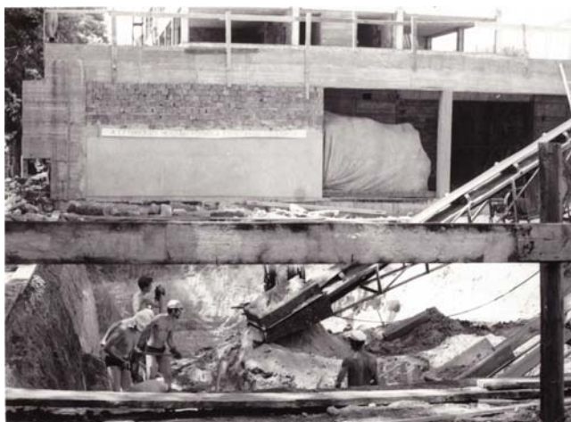
5. ábra. A lépény alapozása. A jobb szélén látható egy cölöp
