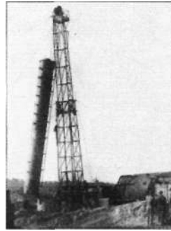
Desztilláló torony beemelése az épülő zalai kőolajfinomítóban (1952)
