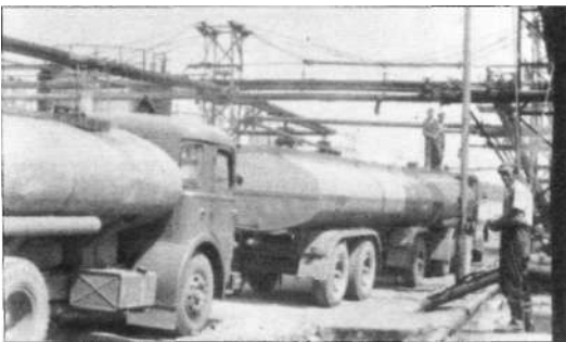
Export-bitumen töltése tankautóba a Zalai Kőolajipari Vállalatnál (1956)
