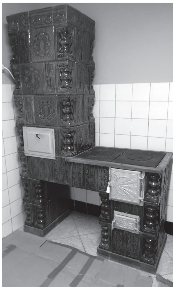
Péter-Pakó Sándor hagyományos cserépkályhái. A kályhacsempék mintázata az úgynevezett kapus vagy kisablakos, megépítésük közös trükkje, hogy a homorítással nagyobb a hőleadó felületük
