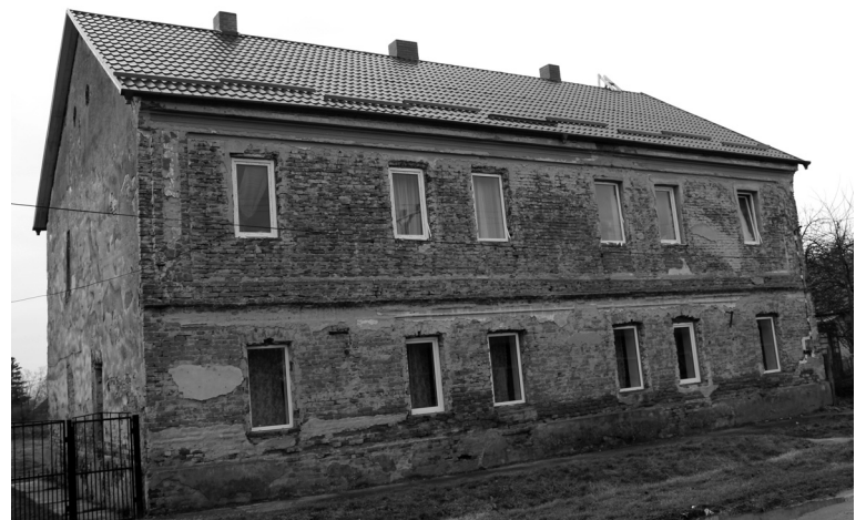
Lemezfödém került az egykori felekezeti iskola épületére
