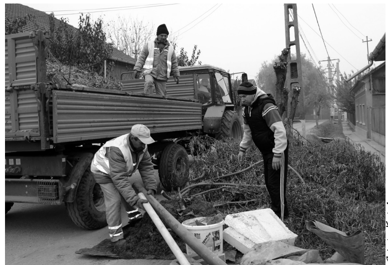
Zöldhulladékokat és építkezési törmelékot is elszállítottak
