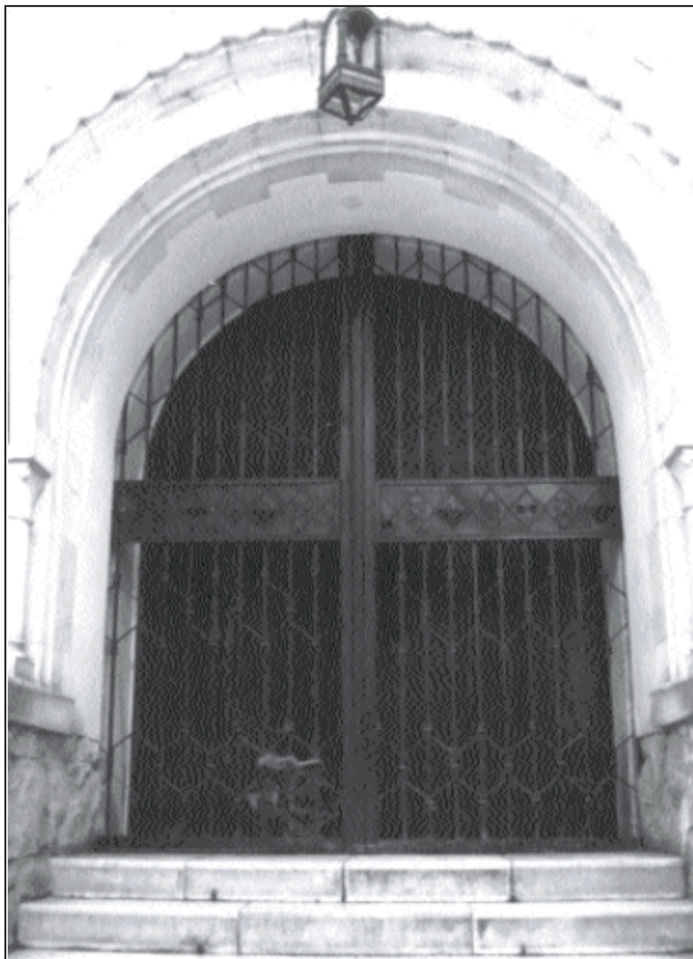
10. ábra A főbejárat megvalósult tolórácsa, lámpása.
