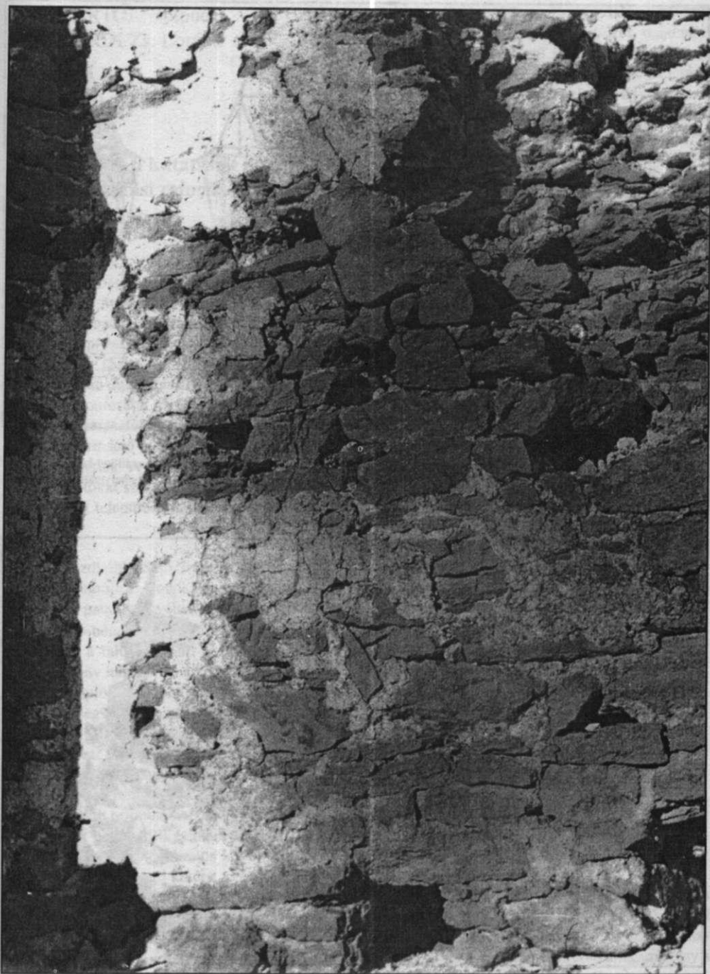
16. ábra Az öregtorony É-i falának belső oldala az emeletváltó gerendák üregével, a sarokkal és a félkörív indulásával
