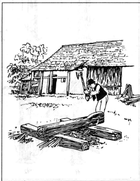
Figura 7. Cioplire brută pe suport de butuci (ambele desene după András CSIKÓS TÓTH).
