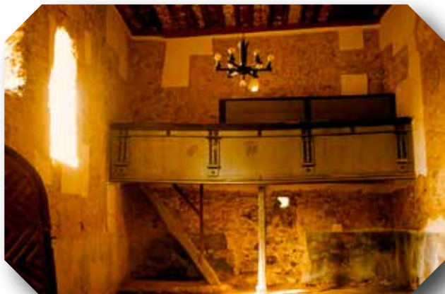
A templombelső falkutatás közben
