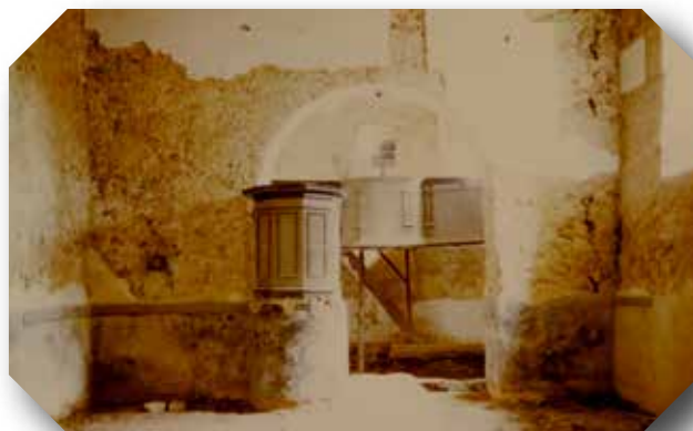
A templombelső falkutatás közben
