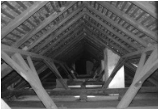
Barokk formájú, ún. dült székes tetőszerkezet 1880-ból az északi szárny fölött. Fotó: B. Benkhard Lilla, 2015
