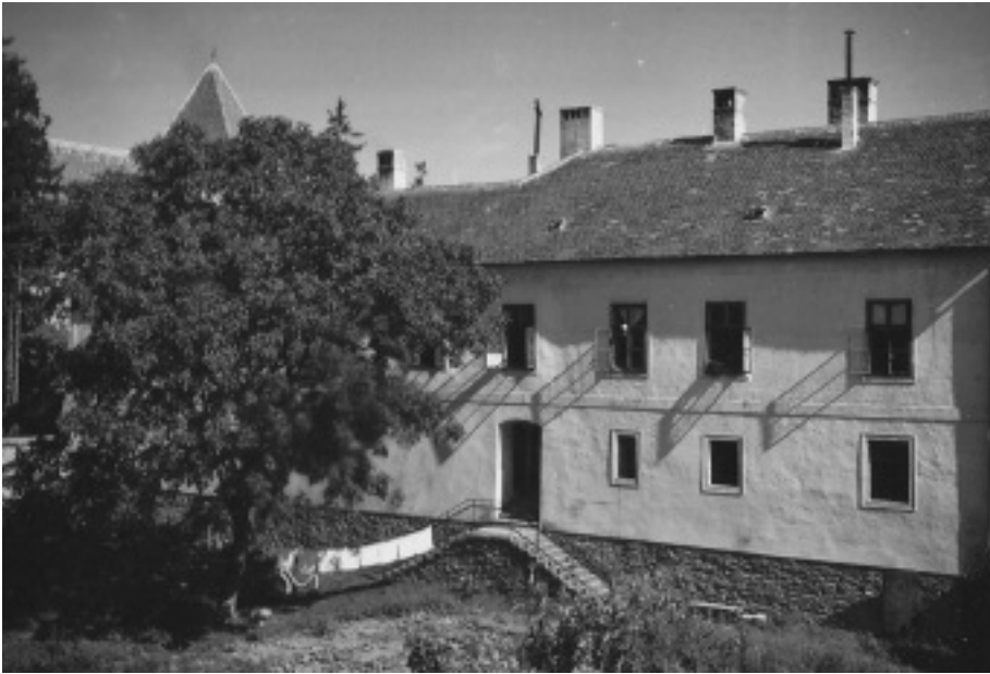
Az egykori kert maradványa az épületből levezető lépcsővel 1959-ben (a család gyűjteményéből)
