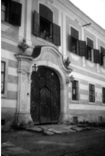
Az utcai homlokzat részlete az 1940-es években (a család gyűjteményéből)
