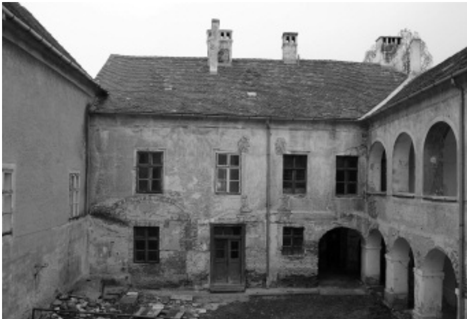
Az udvar nyugati szakasza a XIX. század második felében újonnan felépített épületszárnyal. Fotó: B. Benkhard Lilla, 2015
