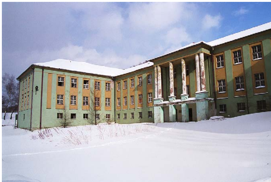
4. kép. A Victoria bánya igazgatóságának elhanyagolt épülete (Fotó: Paweł Pałgan)
