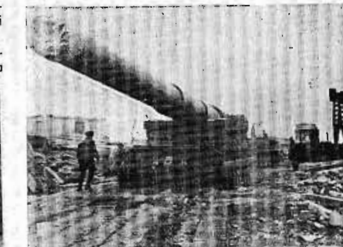
Nehéz löveg szállítása.
