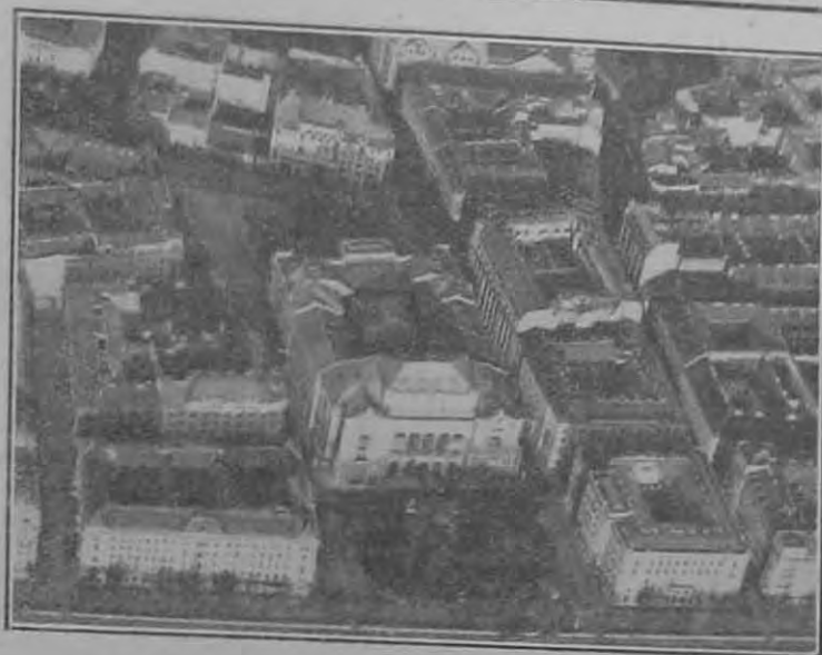
Repülőfelvétel Budapestről: A Vigadó.
