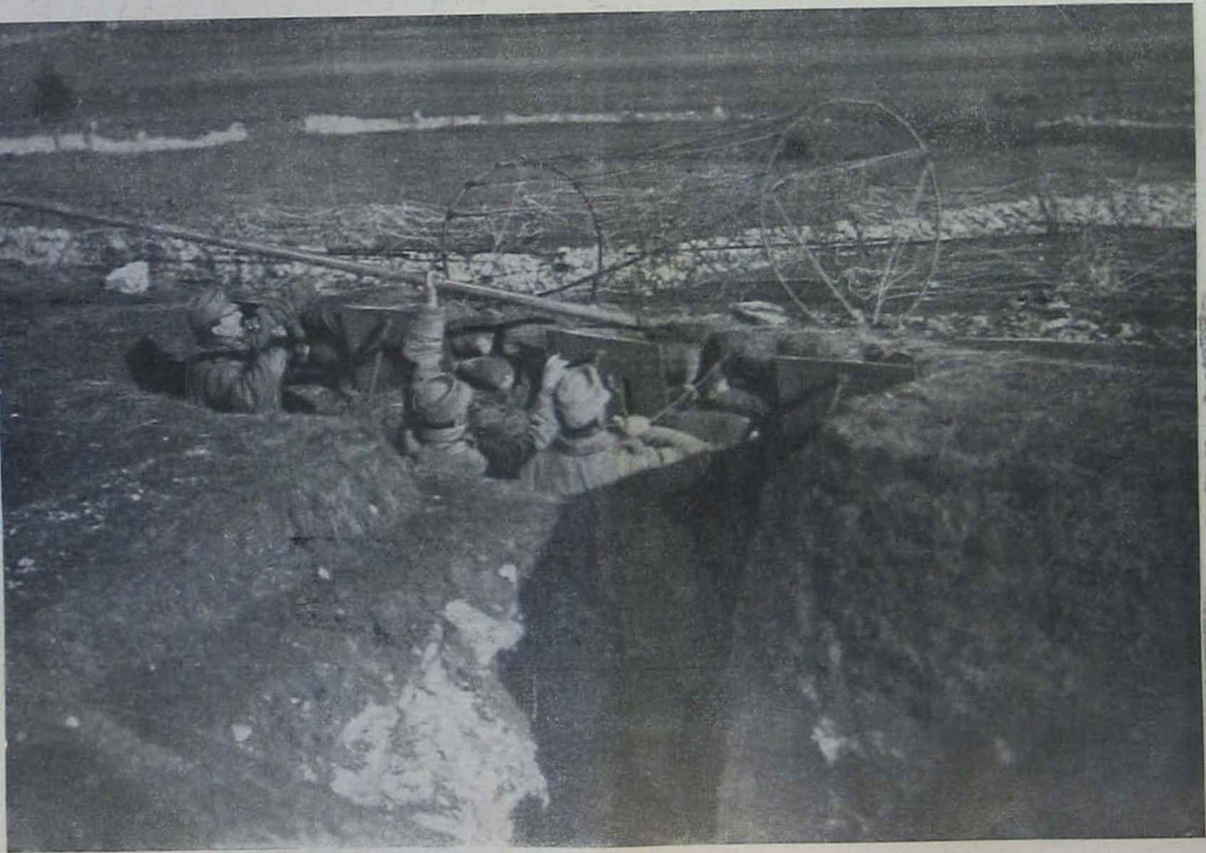
A délnyugati harcztérről. — Henger alakú drótakadályt gurítanak ki a lövészárkból.
