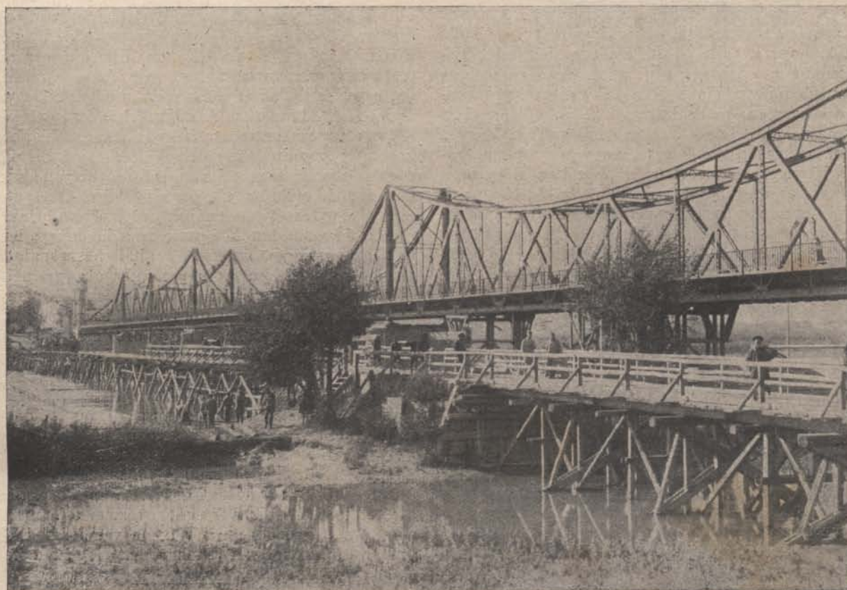
Az északi harcterről. — Felrobbantott viadukt Zotnowka-Potulorynál. — Póthíd a Dnyeszteren,
