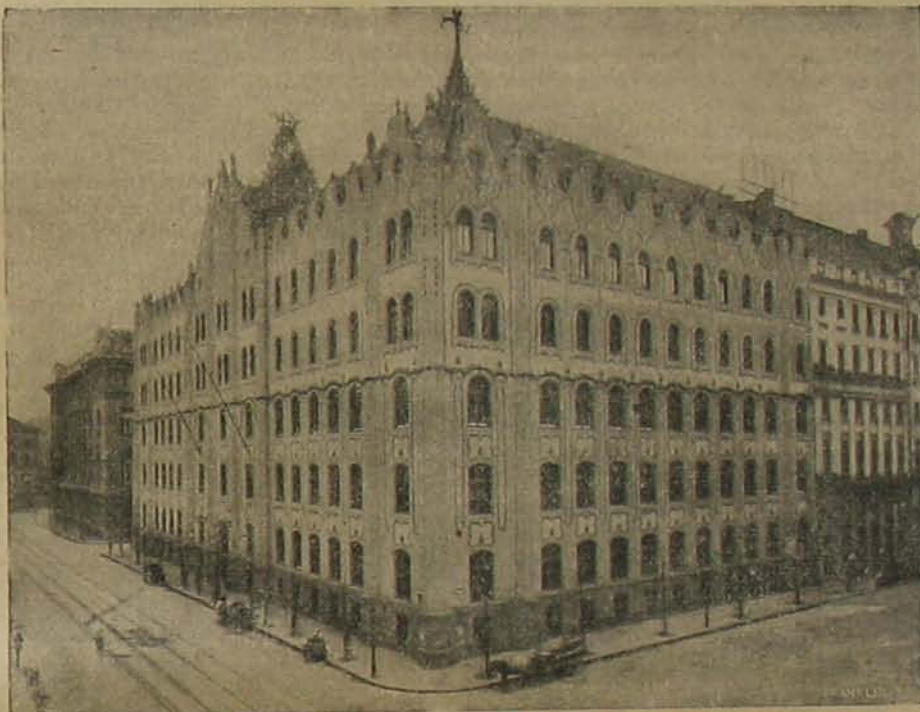
Az épület az utca felől nézve.
