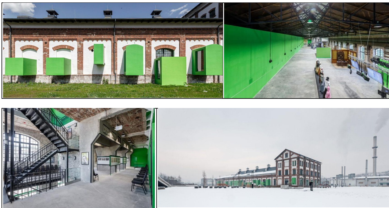
A Nemzeti Filmtörténeti Élménypark épülete felújítás után
