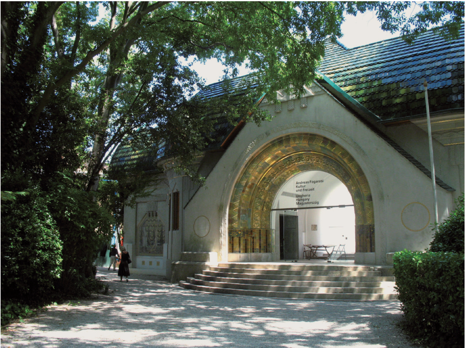
A Magyar Pavilon eredeti állapotának helyreállítása. A főhomlokzat az elkészült új, Csete György által tervezett magastetővel. Velence, Giardini Pubblici, 1999–2000
