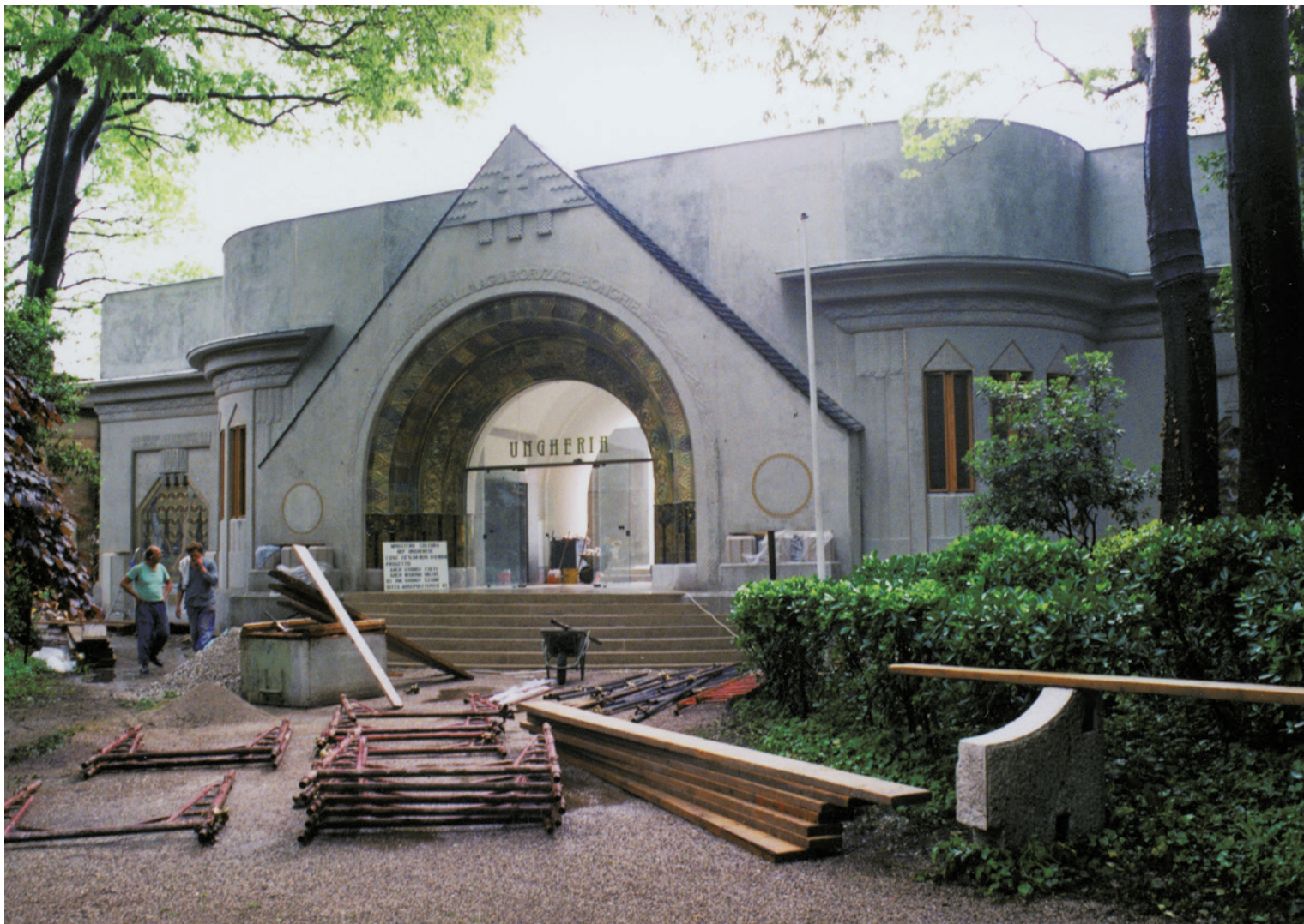
A Magyar Pavilon eredeti állapotának helyreállítása. A főhomlokzat még a Csete György által tervezett új tetőszerkezet nélkül. Velence, Giardini Pubblici, 1995
