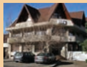
Az épület a Hévízi út felől
