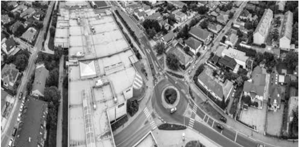
A tervezési területet keletről határoló bevásárlóközpont beékelődik a kertvárosias szövetbe. Drónfotó, 2020. május
