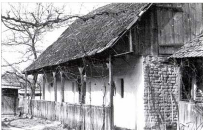
XVIII. szd. végén épült vályogtégla falú parasztház (Szilágynagyfalu, Nagy utca)
