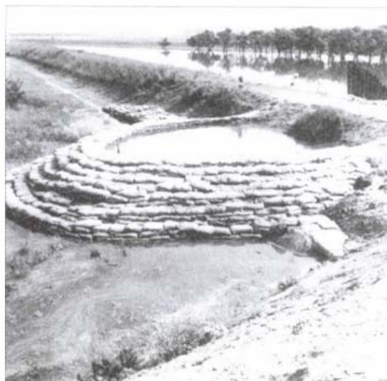
A töltés mentett oldalán kialakuló, homokzsákokkal körbezárt buzgár, 1970.
