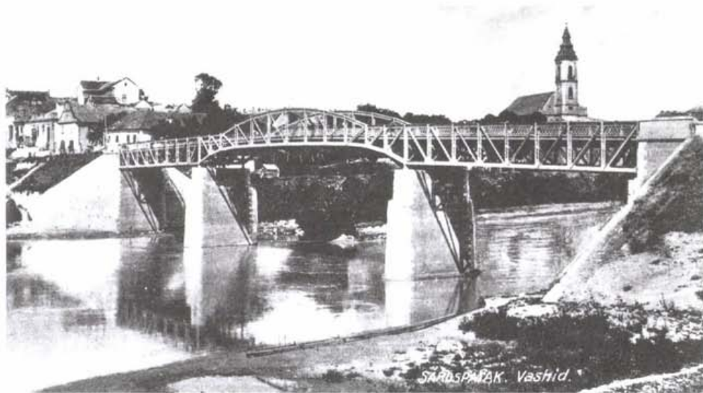
Sárospatak, Bodroghíd. Épült 1909–1910.
