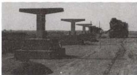
Az iszapelvezető csőrendszer betonoszlopai
