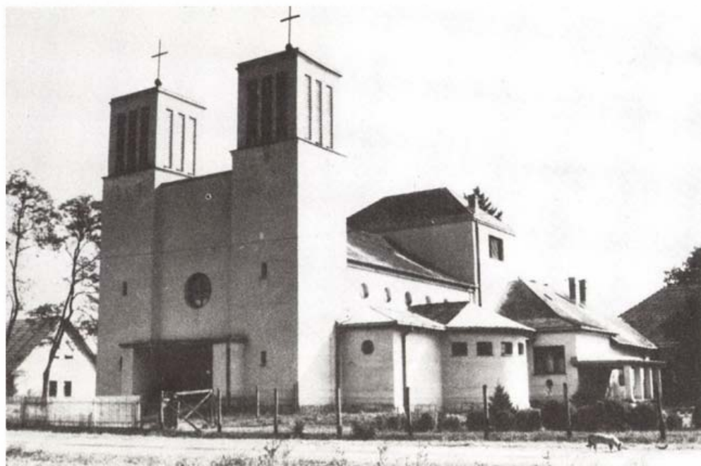
A tiszaújfalui zárdateplom – 1942.
