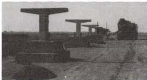
Az iszapelvezető csőrendszer betonoszlopai
