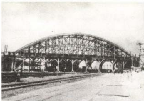
A repülőtérre vezető út nagy hidjának egyik szakasza épülőben, 1941–42
