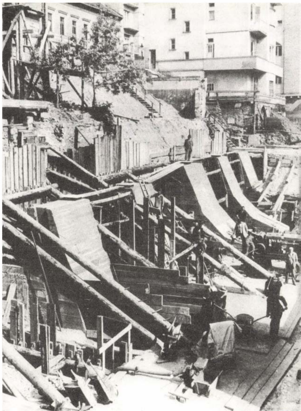
A várhegyi hegycsuszamlás támfalának építése, 1935–36
