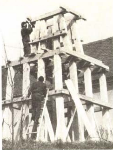
A szeghalmi ácsok felépítették a gerendavázat
