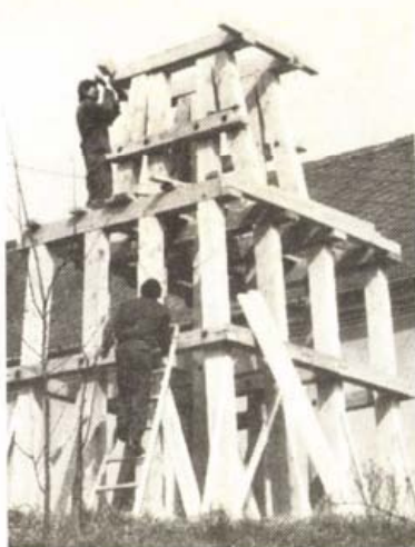
A szeghalmi ácsok felépítették a gerendavázat
