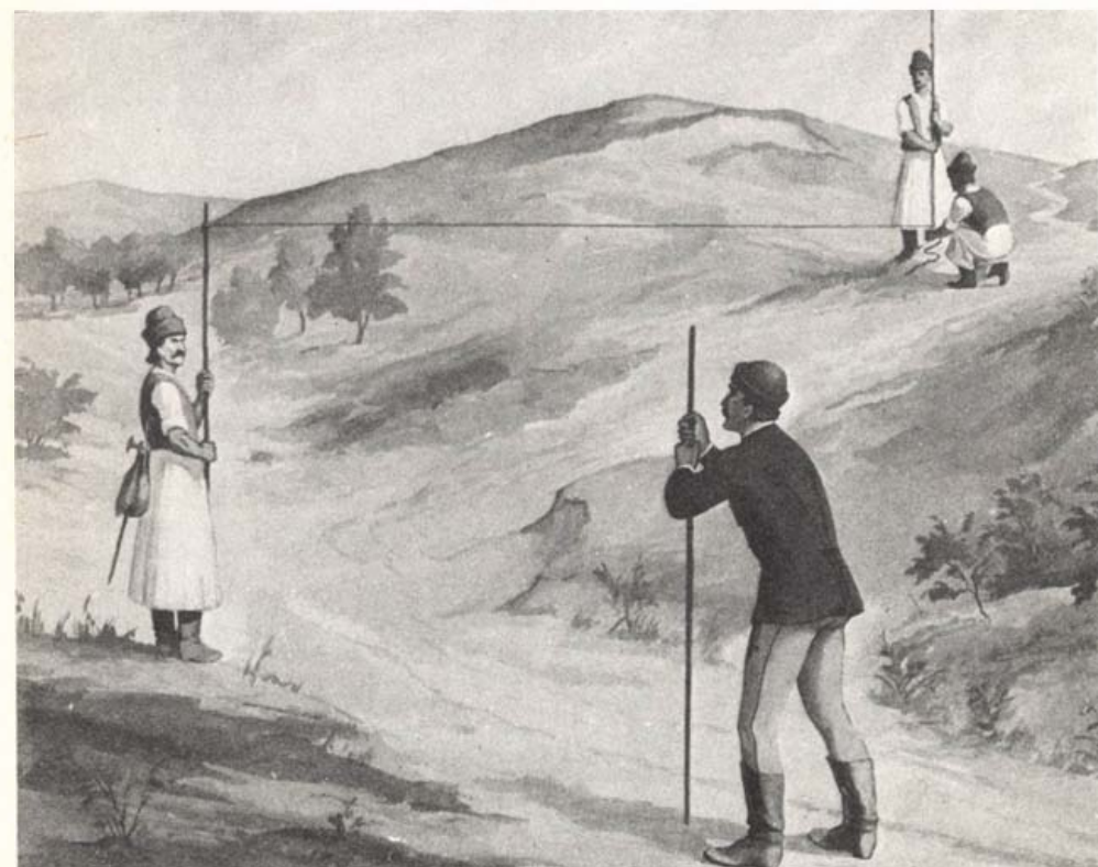
Vízszintes hossz mérése mérőkötéllel lejtős terepen (XVIII. sz. második fele)
