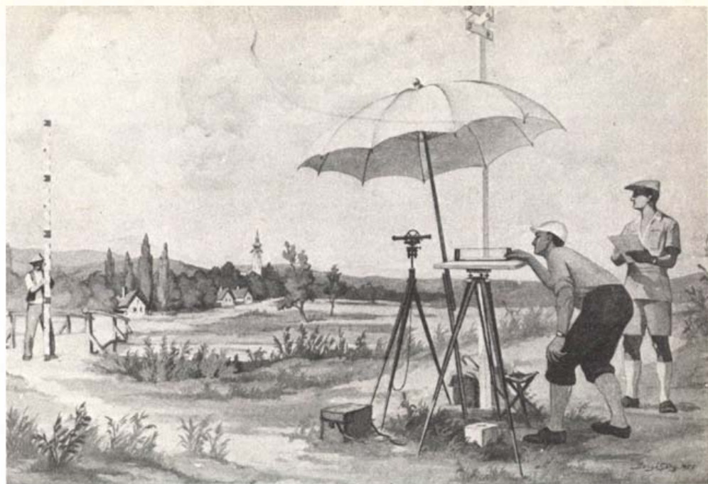
Terepfelmérés mérőasztállal, magasság- és távolságmérő műszerrel (XX. sz. első évtizedei)
