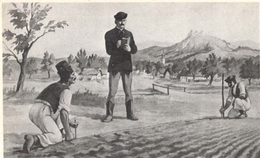
Hosszmérés mérőlánccal: a telek sarokpontján kitézőpózna a láncvégeknél cövek (XVIII. sz. második fele)
