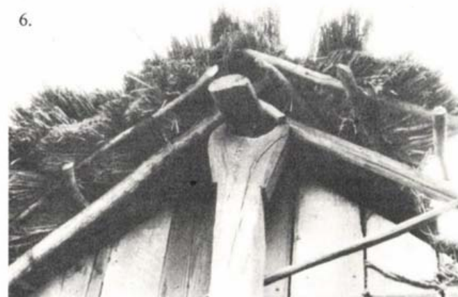
6. Ágasfás tetőszerkezet (Dedki)
