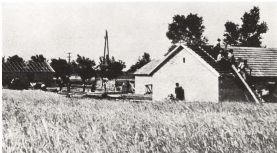
Ahol Duanújváros építése elkezdődött. Épülő barakok a Délivárosban
