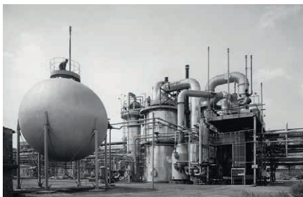
ATMOSZFERIKUS FÖLDGÁZBONTÓ AMMÓNIAGYÁRTÁSHOZ
