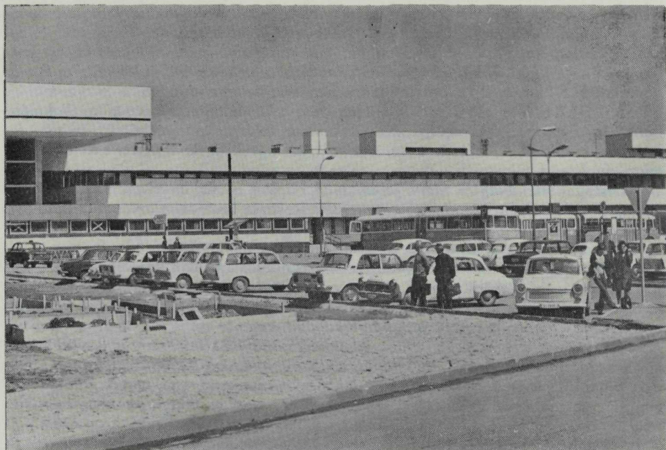
Az épülő szolnoki vasútállomás (Foto: Boros)
