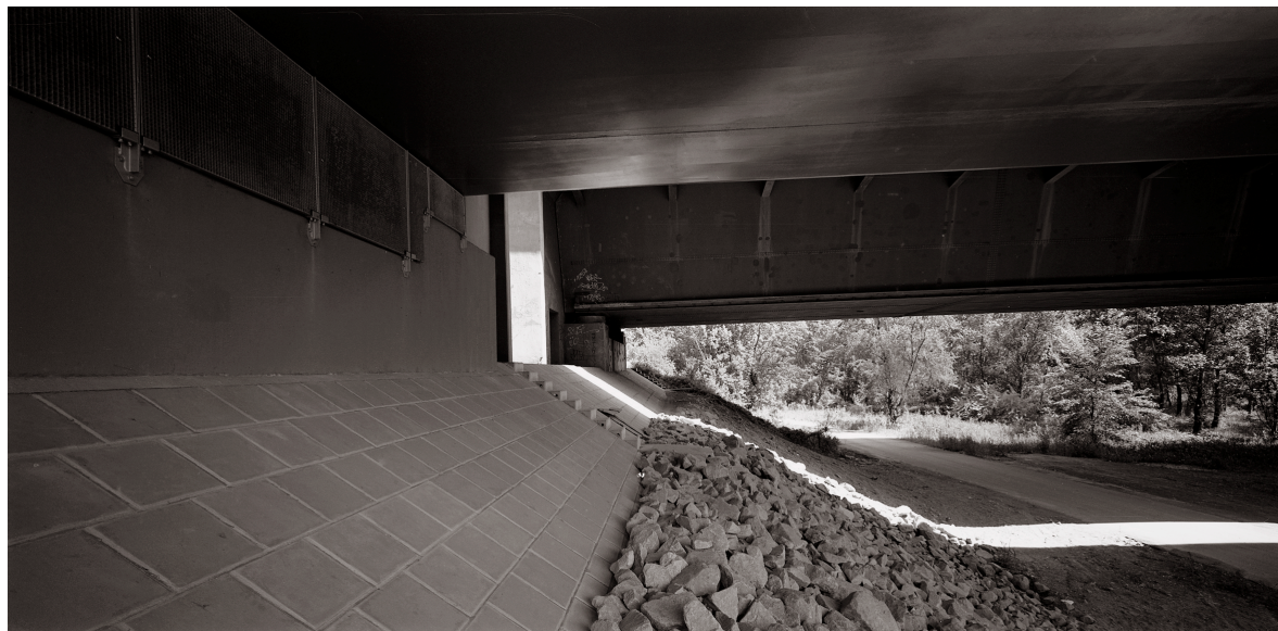
M0-ás híd, Nagytétény, 2015
