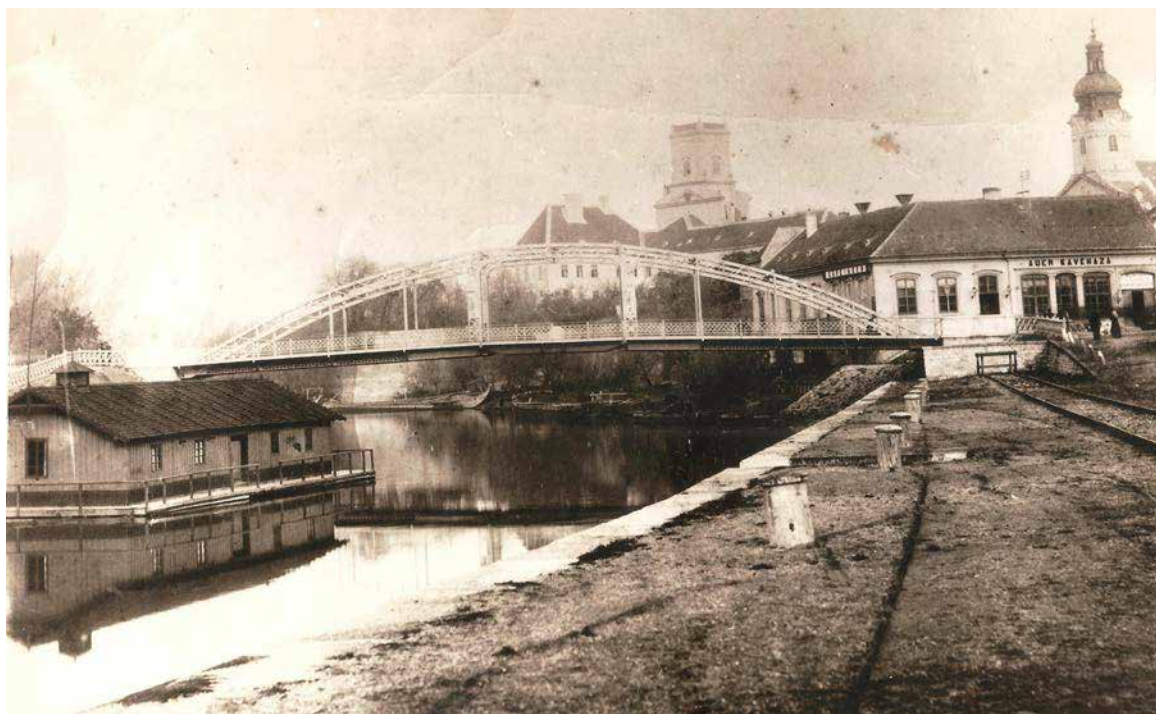
A sétatéri nagy híd 1900-ban. 1894. február 20-án adták át a hivatalkának. A híd középrésze felvonható volt, így a Győr–Sopron–Ebenfurti vasút rakodóját az uszályok megközelíthették.
