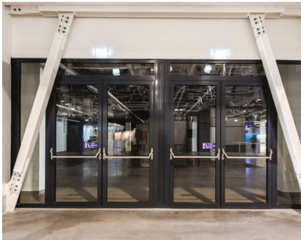
Coolfire-Sapa 74 EI60 tűzgátló üvegezett portál, C5 (200ezer nyitásciklus) intenzív használatra, menekülési útvonalra rozsdamentes GU pánikrudazattal
