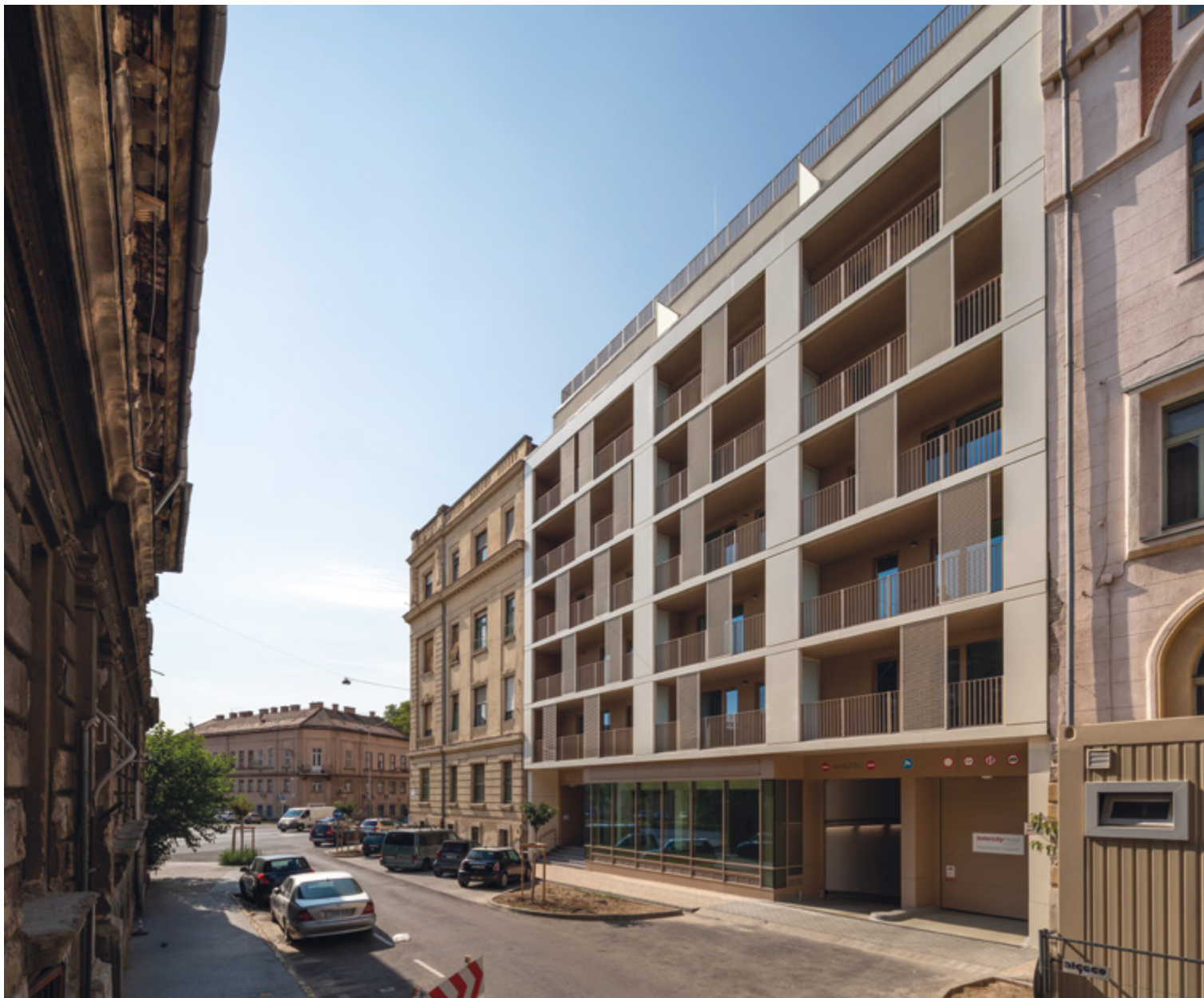
A Mosonyi utcai homlokzat. A 45 lakásos apartmanház és a szálloda egymástól függetlenül működik, csak a garázs szint maradt közös.
