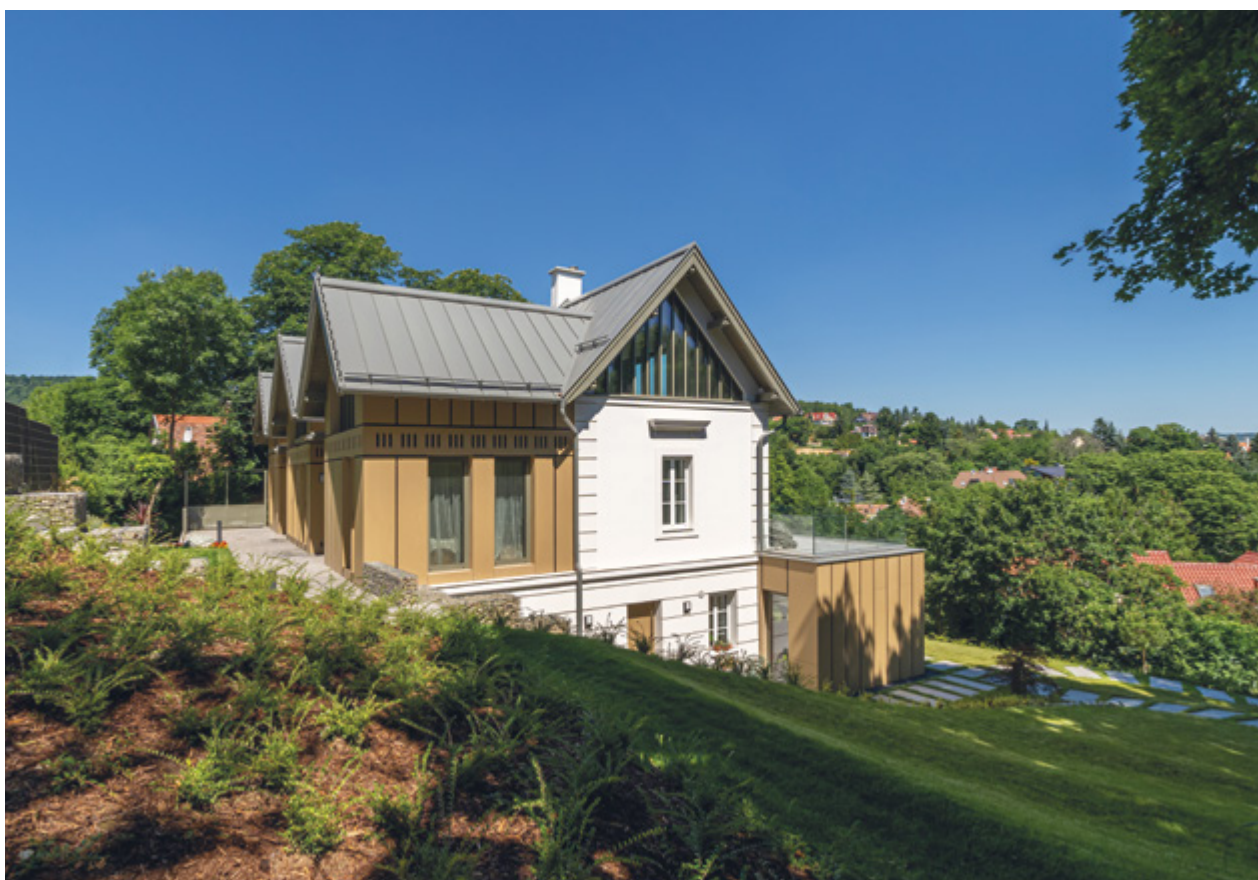
Az épület keleti homlokzatán jól látható a régi és új épületrészek találkozásának harmóniája
